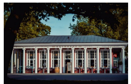
Das renommierte Restaurant Kolonade
